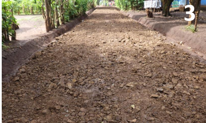
写真1. 2. 3. B村にて2019年11月～12月にかけて撮影。試験施工実施に向け、小規模な道路補修を実施するデモンストレーションを行った。B村村長を中心にB村初等学校前の約150メートルの通学路をデモのためのサイトとして選定。雨が降っていたため工事の実施スケジュールの調整や参加の程度や組織化・情報共有等について、いくつか課題が見出された。工事自体は側溝の最終作業をのぞいて予定通り終了した。上記資料は、住民説明用の作業フロー図。
